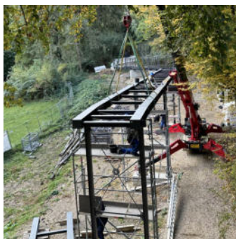
Einzelne Brückenteile werden verbunden
