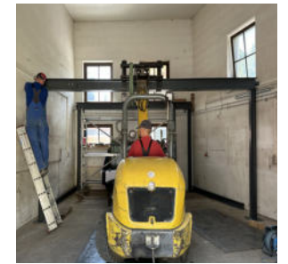
Einbau eines Lagerbodens
