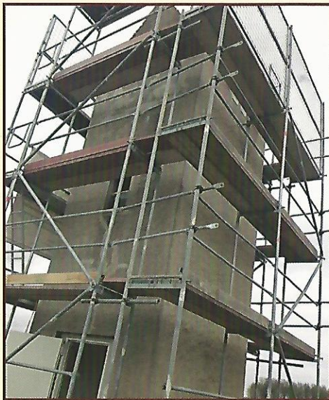
Ein Trafohaus wird zum Wildtier-Hotel umgebaut
