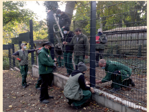
Abschluss der Zaunsanierung
