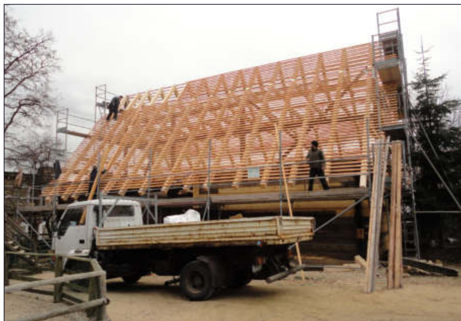
Die Schrotholzscheune bekommt ein neues Biberschwanzdach
