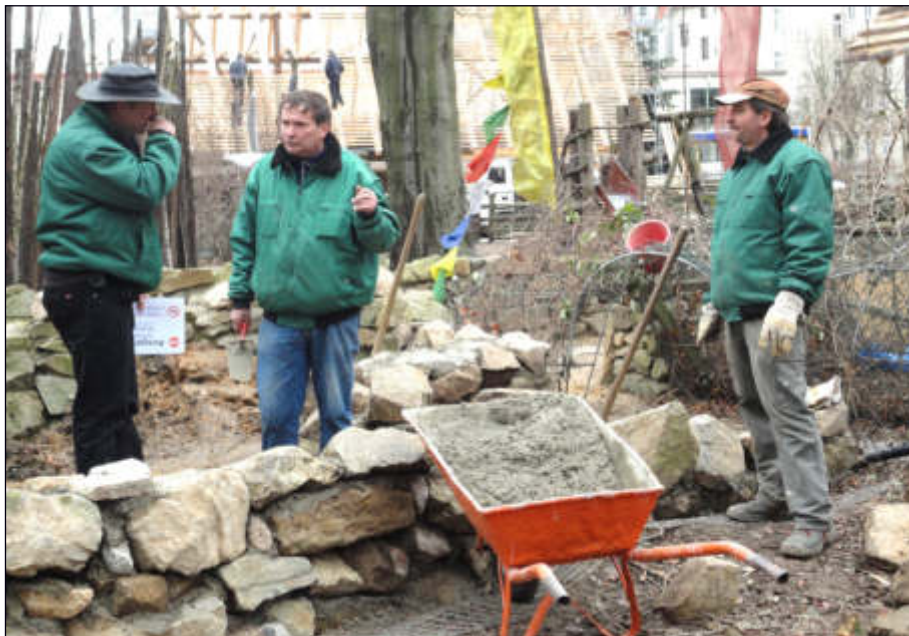
Umbau der Stachelschweinanlage im Tibet-Dorf
