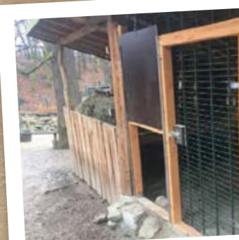
Fanganlage mit Vertikalschieber
