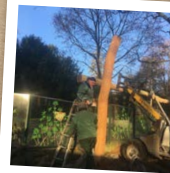
Erste Pfeiler der neuen Panda-Terrasse
