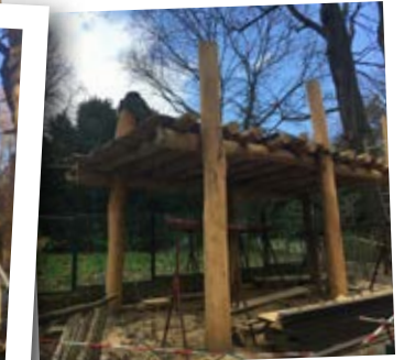
Bau der Panda-Terrasse
