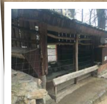
Fanganlage Steinbock - Besucheransicht
