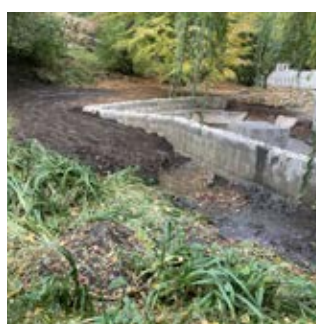
Verfüllen mit Lehm und Anbringen der Bepflanzung
