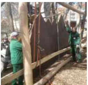
Bau der Kletterwand
